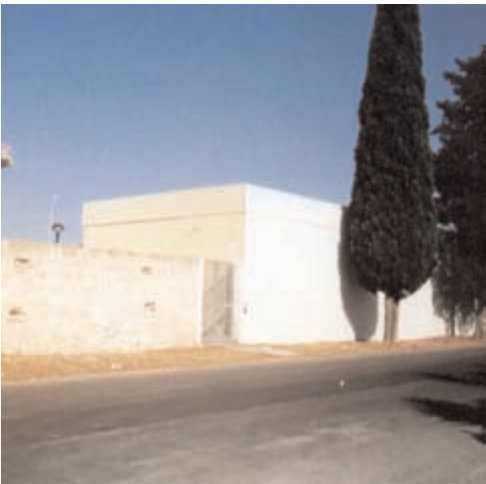
Recuperare il tempo trascorso ed avviare i lavori di ristrutturazione dell’ex mattatoio in centro per la formazione professionale
