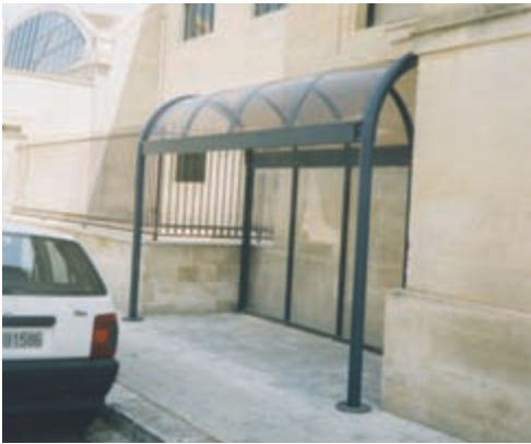
Pensilina fermata autobus da sistemare dove serve per esempio in viale Colaci
