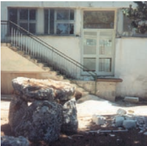
Rendere sicuri tutti gli accessi alla scuola media, è l’unico sistema per evitare furti ed atti vandalici al patrimonio pubblico
